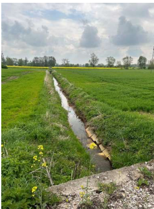
Fot. 69. Rów melioracyjny w dobrym stanie – miejscowość Włóki.
