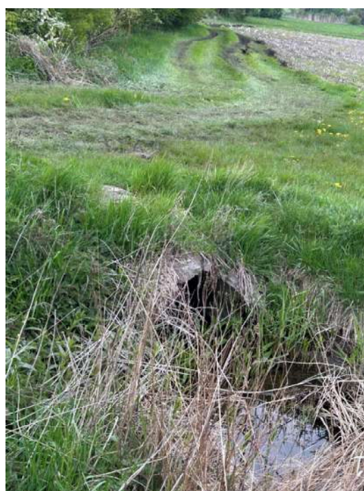
Fot. 68. Przepust na rzece w miejscowości Rogowo.
