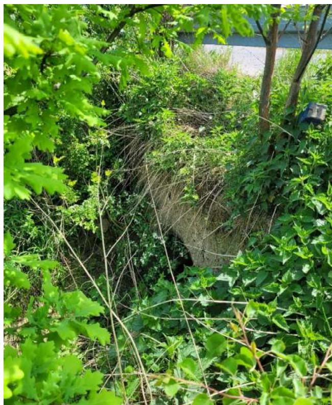
Fot. 4. Rów w miejscowości Łubki Stare.
