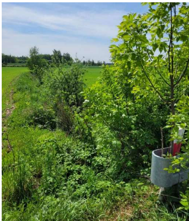
Fot. 3. Rów w miejscowości Łubki Stare.
