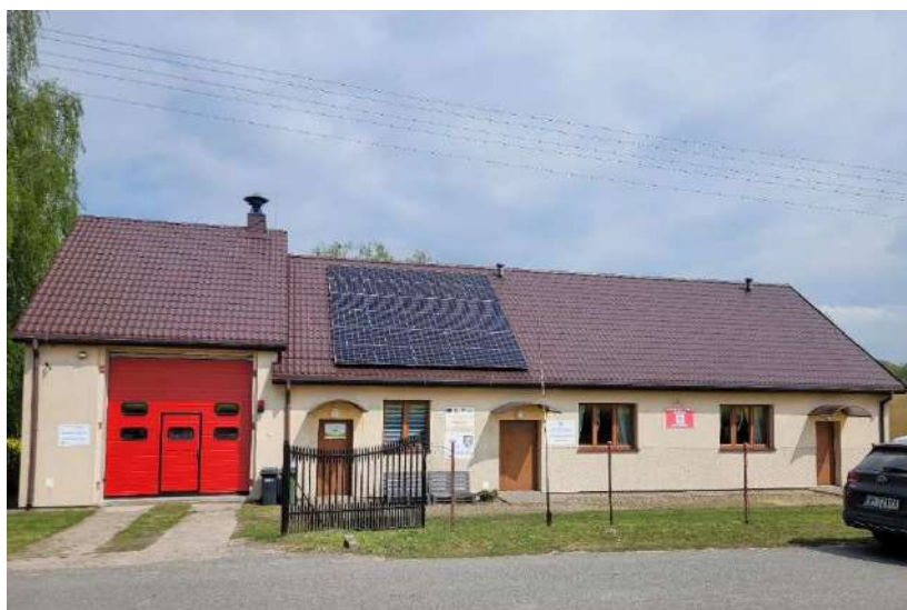
Fot. 43. Remiza Ochotniczej Straży Pożarnej w Pilichówko.
