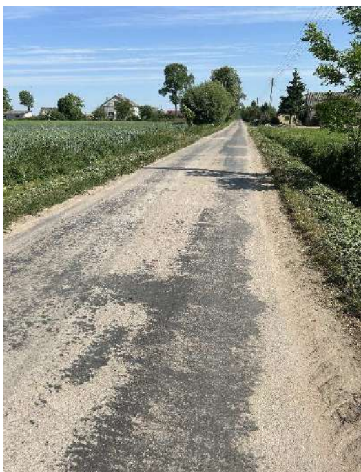
Fot. 73. Droga gminna – Bulkowo Kolonia .
