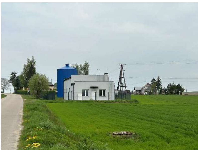
Fot. 53. Stacja uzdatniania wody w miejscowości Włóki.
