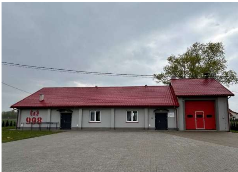
Fot. 41. Remiza Ochotniczej Straży Pożarnej w Nadutki.
